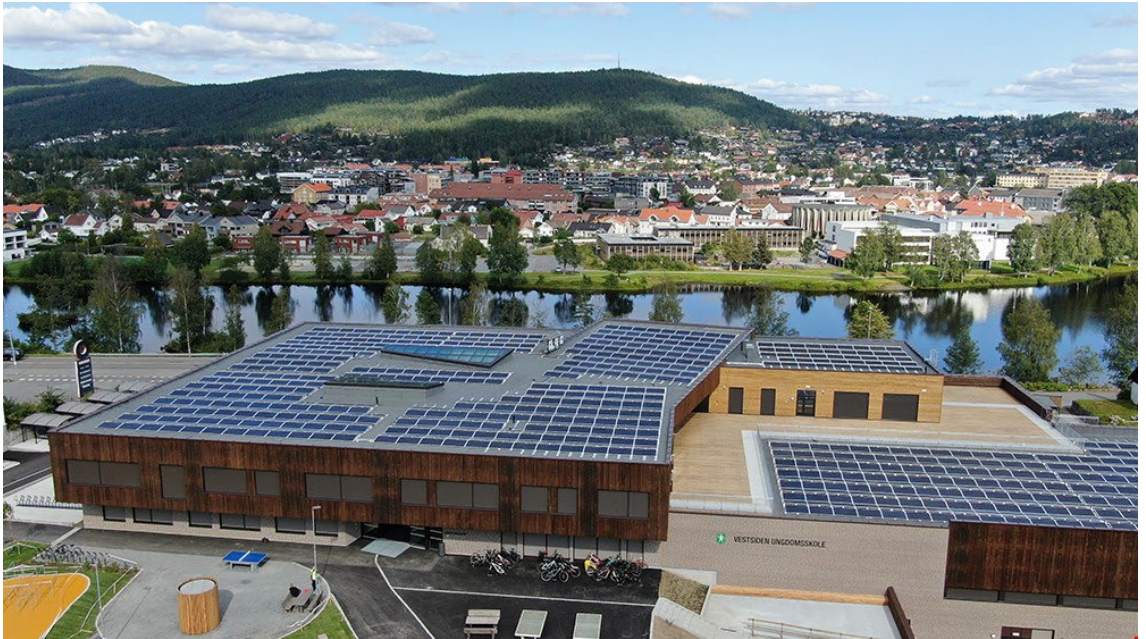
Vestsiden ungdomsskole i Kongsberg ble ferdigstilt skoleåret 2019/202. Foto: Enova
