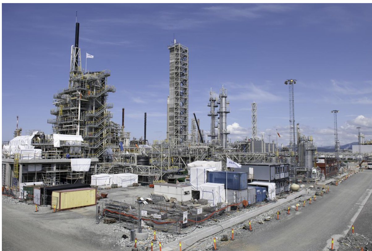
Testsentret på Mongstad under utbygging. Foto: Helge Hansen
